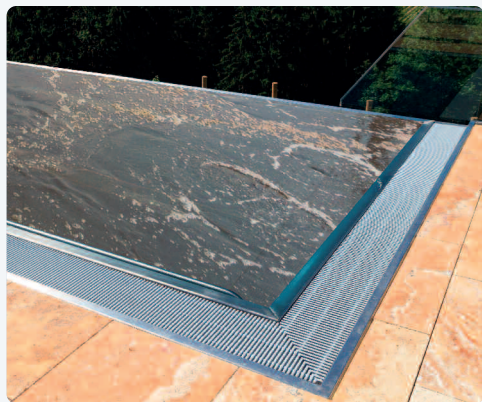
Bazén před úpravou
